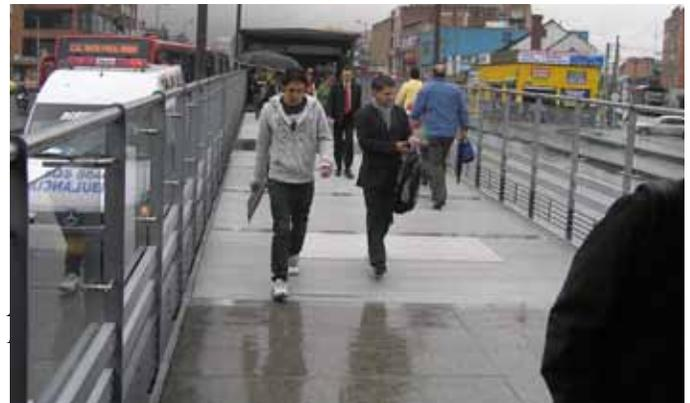
*TransMilenio 2011: las barandas de protección a lo largo de las conexiones entre plataformas fueron elevadas para que sean más difícil de escalar. Se recomienda de este tipo más alto de barandilla en las conexiones entre plataformas al interior de la estación. Foto de EMBARQ.*
